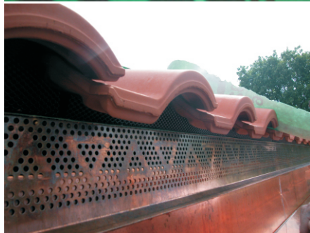
Realizzazione di una camera di ventilazione
